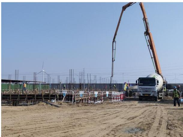
采用商品混凝土施工
