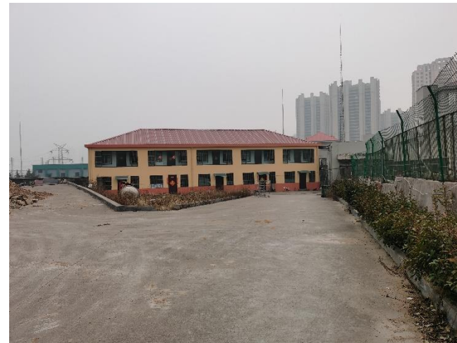
站址西北侧 1.5m 的工厂宿舍楼
