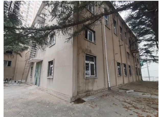
现有 110kV 配电装置室
