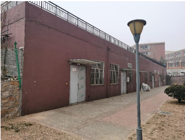
站址西北侧 1.5m 的滨海康城小区物业用房
