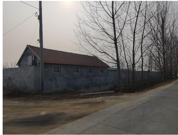
站址南侧合作社办公室
