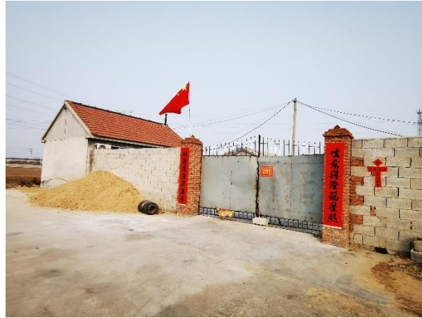
1-2 线南 37m 潘家洼村北侧看护房
