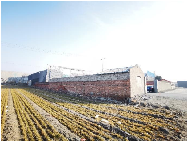
2-6 线南 15m 青岛福鑫石墨有限公司厂房
