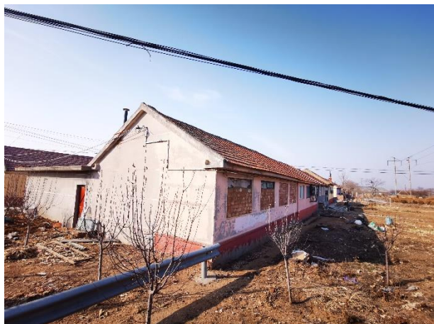
2-9 线南 20m 荆家寨村北侧民房
