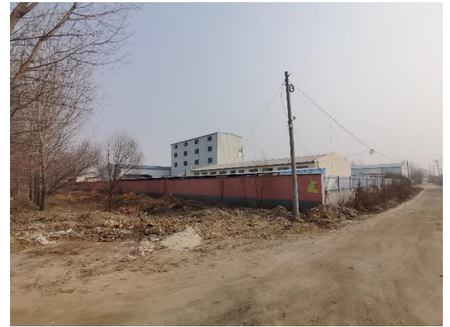
站址南侧织带公司办公室
