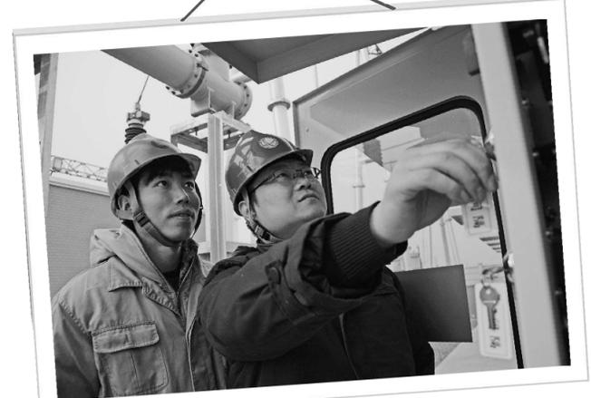
图为何鑫刚(右)和同事检查GIS设备传动机构。
