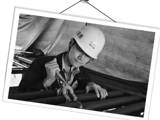
图为赵瑞正在进行钢架管排对口质量检查。
