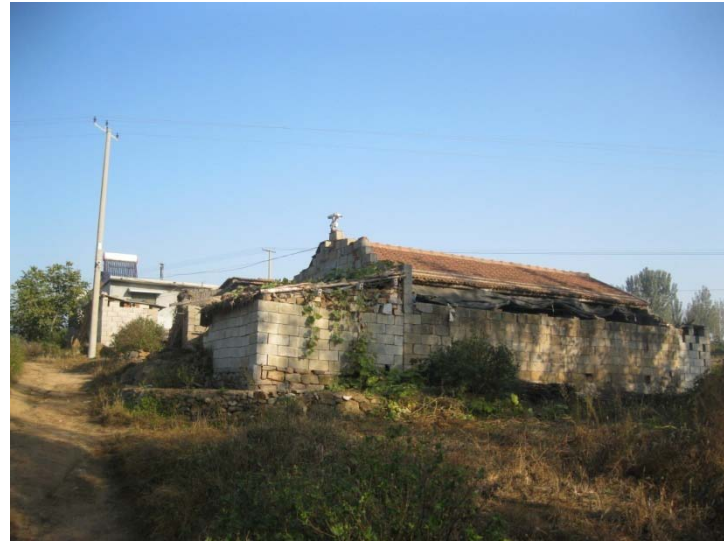
线路东侧 14m 的小城西村西侧养殖看护房
