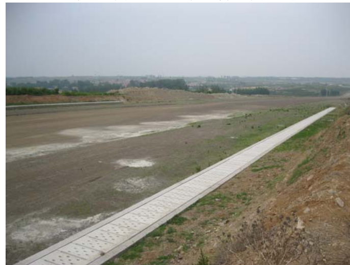
在建潍蓝路南侧线路路径概况
