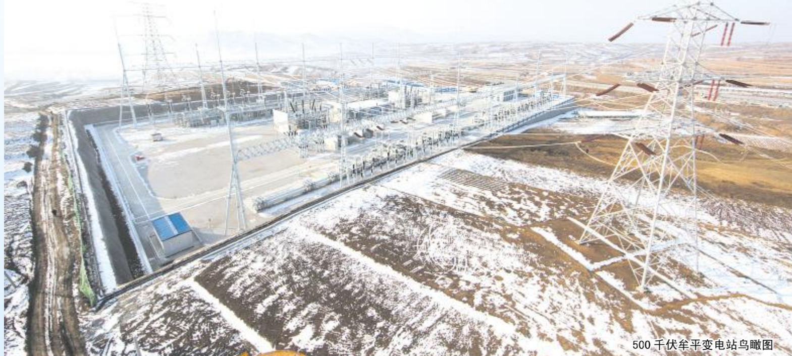
500千伏牟平变电站鸟瞰图
